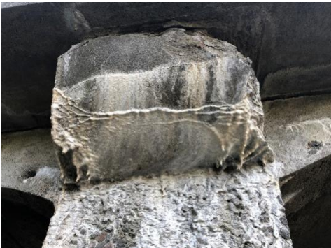
Rys. 4. Uszkodzenia wsporników (konsol) kap
