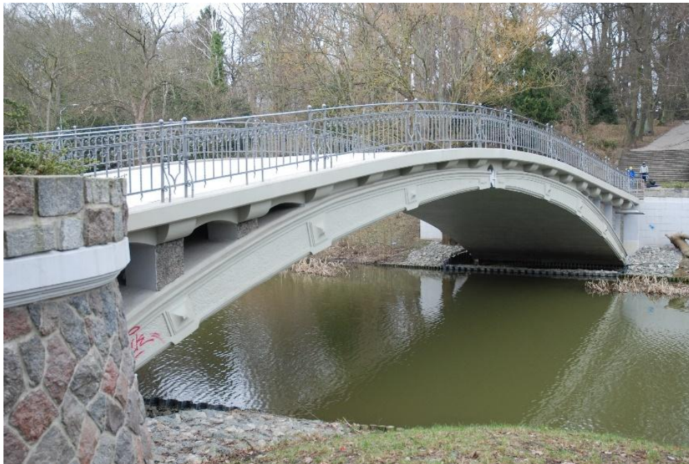
Rys. 13. Widok na most od strony dolnej wody po remoncie
