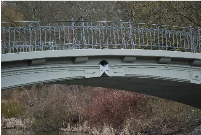
Rys. 10. Widok wezgławia łuku wraz z zabytkowymi balustradami
