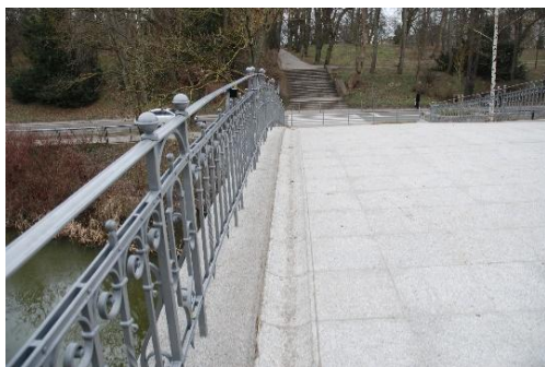
Rys. 11. Widok nowej nawierzchni mostu
