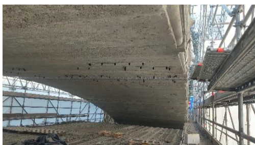
Rys. 6. Wykonanie wzmocnienia płyty pomostu Rys. 7. Iniekcja rys spękań łuku
