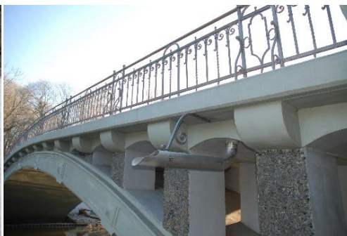
Rys. 12. Nowe „rzygacze” do odprowadzania wody z odwodnieniem
