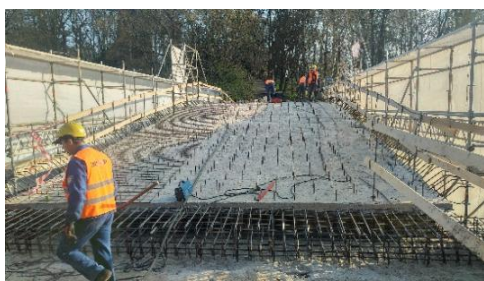
Rys. 6. Wykonanie wzmocnienia płyty pomostu Rys. 7. Iniekcja rys spękań łuku
